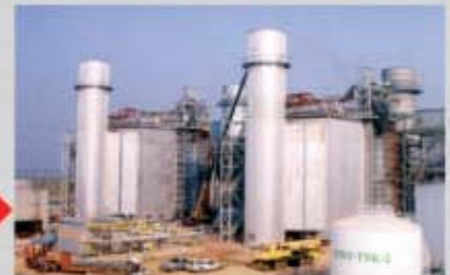
Ratchaburi Combine Cycle Project Installation of HRSG x 2 units
